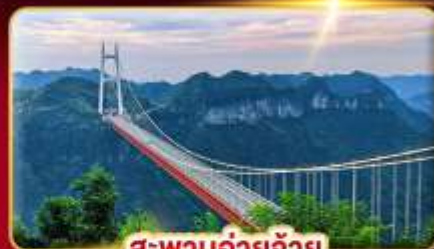
สะพานอ้ายจ้าย
